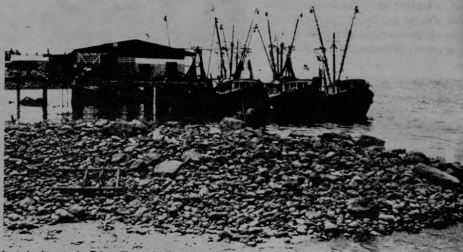
Instalaciones de Frigoríficos de Puntarenas.
